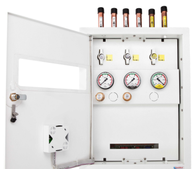
Контрольно-газорозподільна шафа для 3 газів верх-верх
